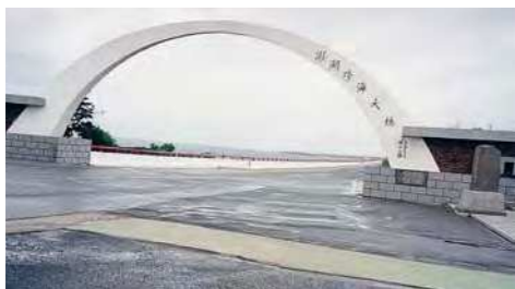
澎湖跨海大橋
